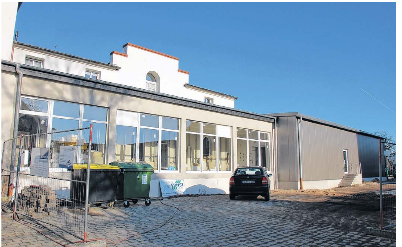
Im Oktober wurde das Becken eingesetzt, inzwischen ist die Halle darüber gebaut worden (rechts).
